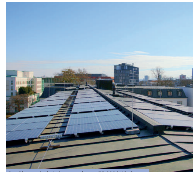
Die Photovoltaik-Anlage produziert 75.000 kWh Strom.
